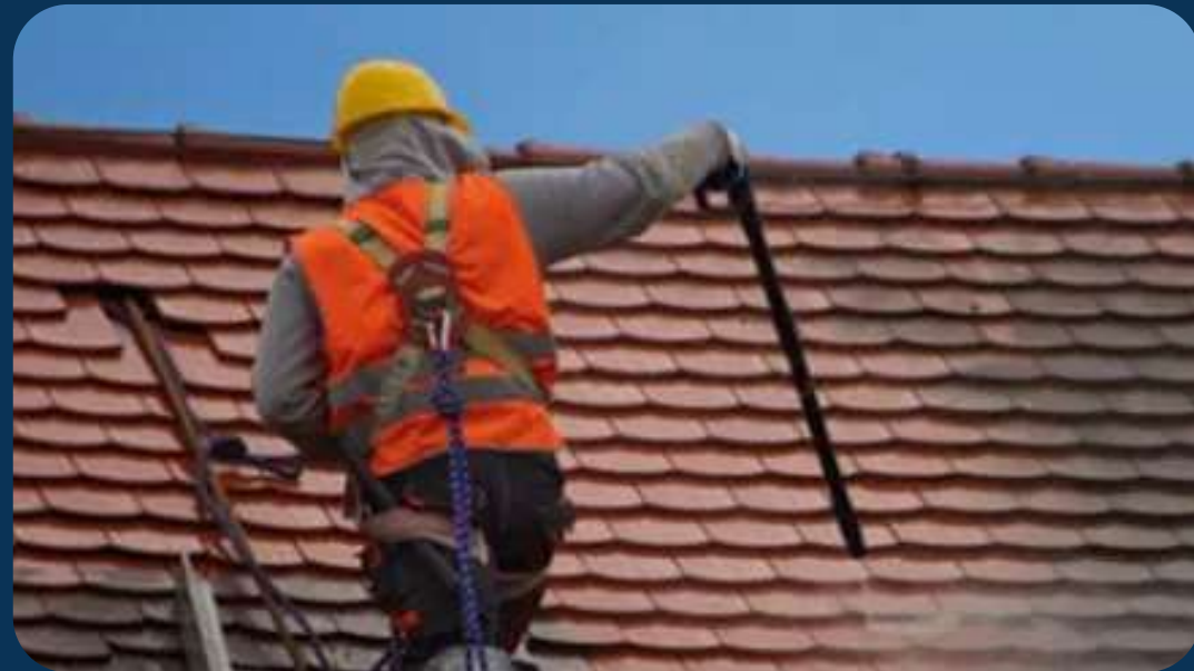
TEJADOS Y CUBIERTAS
