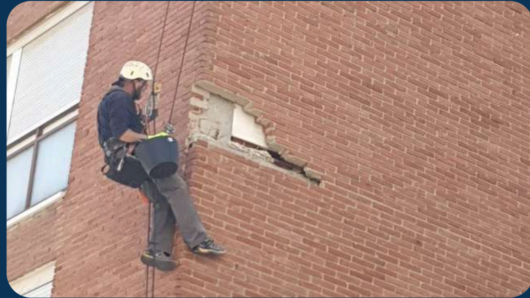
REHABILITACIÓN DE FACHADAS
